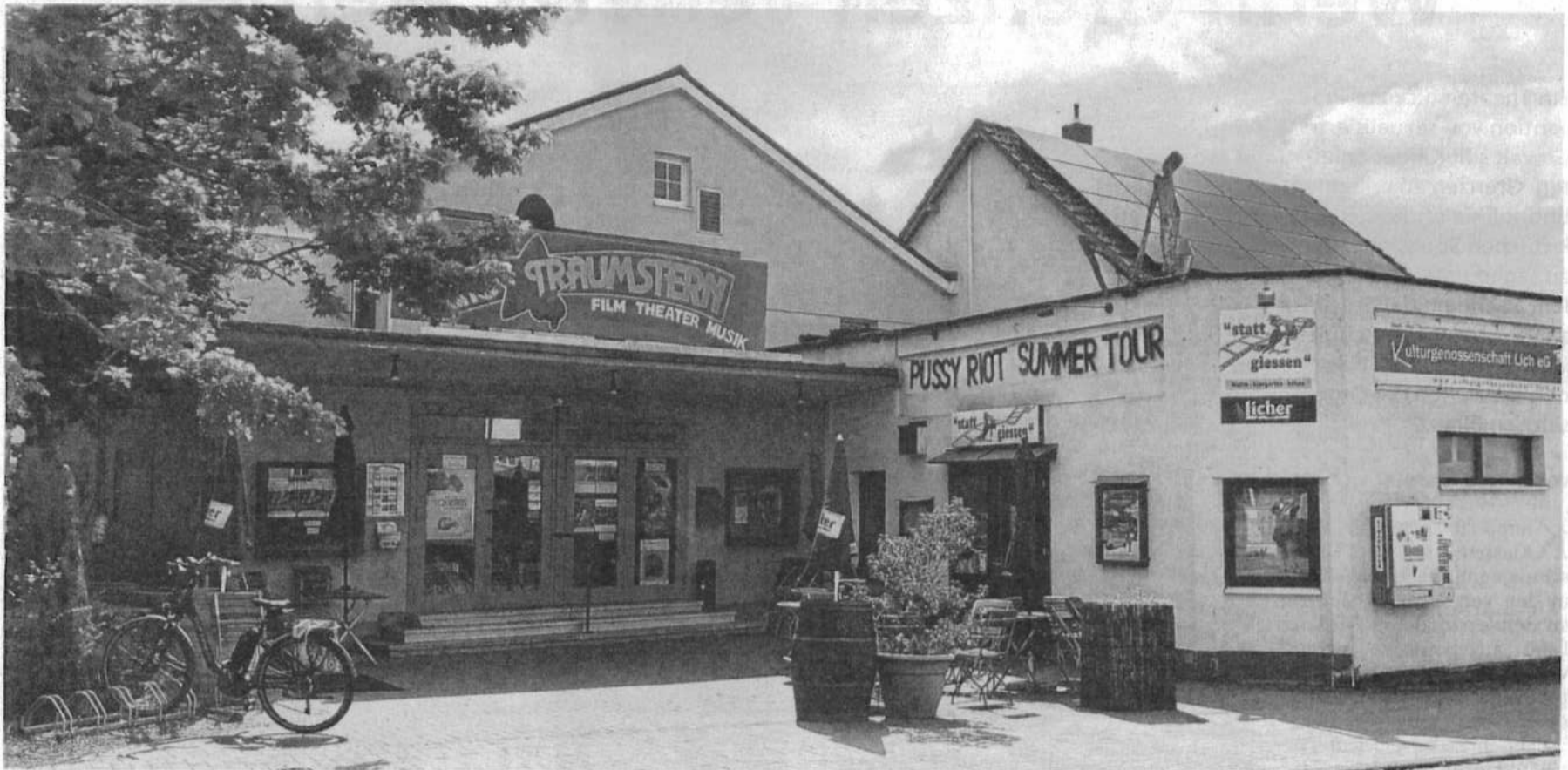
Seit dem 18. Juni bezieht das Kino Traumstern seinen Strom von der Sonne. Von der Straße aus ist nur ein Teil der neuen Photovoltaik-Anlage zu erkennen, die auf dem Nebengebäude und über der Kneipe errichtet worden ist. Das dünne Blechdach über dem Kino erschien dafür nicht geeignet. FOTO: US
